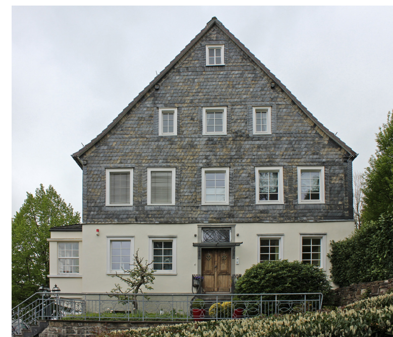
Lochfassade, Am Kerberg 2
